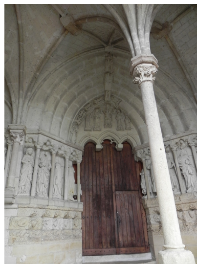
Porche d'entrée du bras de transept nord. Colonnnette monolithe recevant la retombée des voûtes et niches trilobées garnies de statues en ronde-bosse.
