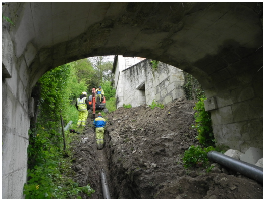
Pendage du terrain et passage sous voûtes de très faible hauteur.
