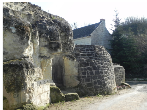
Mur de rempart appuyé sur l'éperon rocheux de tuffeau calcaire, rue des Perrières (extrémité Est).
