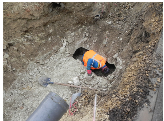
Percement de cavités sous voirie.
