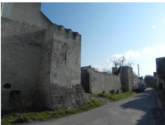
Mur de rempart de la cité fortifiée médiévale, rue des Perrières.
