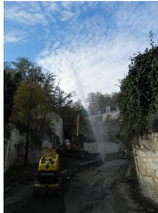
Percement de réseaux existants.
