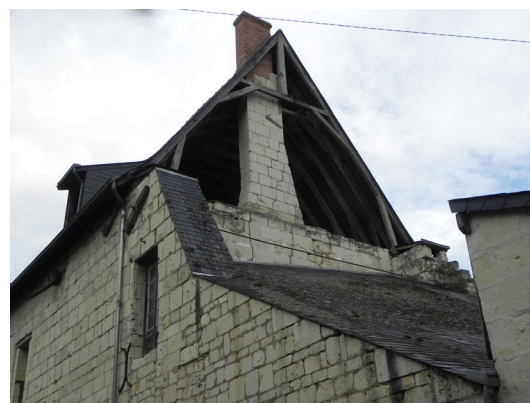
Charpente de l'Hôtel de la Prévôté.
