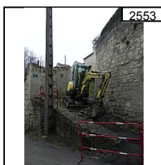
2553 Tranchée chemin du Tire-Jarret.
