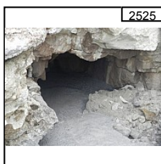
2525 Cave percée puis bétonnée rue Trochet (après n°15)
