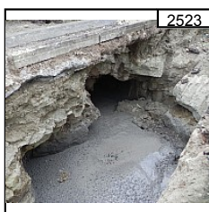
2523 Cave percée puis bétonnée rue Trochet (après n°15)
