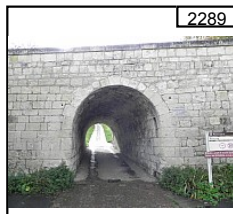
2289 Rue de la Douve et pont féodal.
