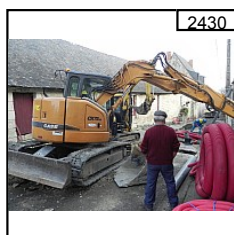
Condition de travail, deux pelles mécaniques
