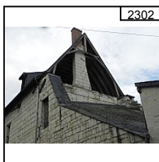
2302 Charpente de la maison de la Prévôté.
