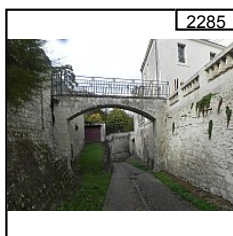
2285 Rue de la Douve.
