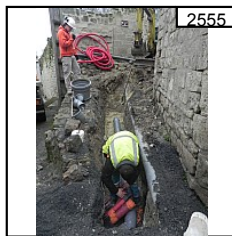
2555 Tranchée chemin du Tire-Jarret.
