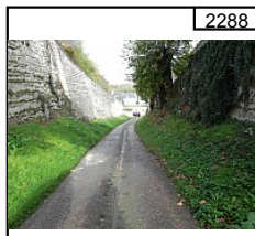
2288 Rue de la Douve.
