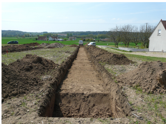
Tranchée 1. Vue vers l'ouest
