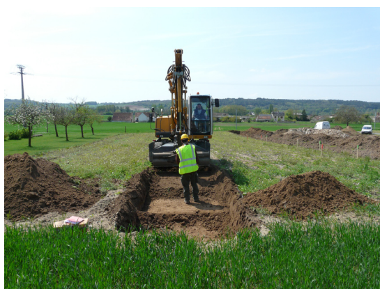
Tranchée 4. Vue vers l'ouest
