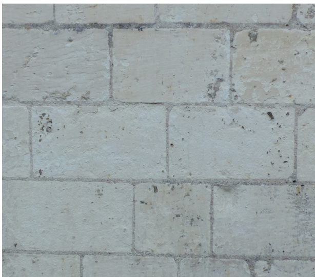
Figure 38 : Exemple d'emploi du tuffeau blanc, « faciès blanc », pour le parement de la Tour du fortin (©Sadil)
