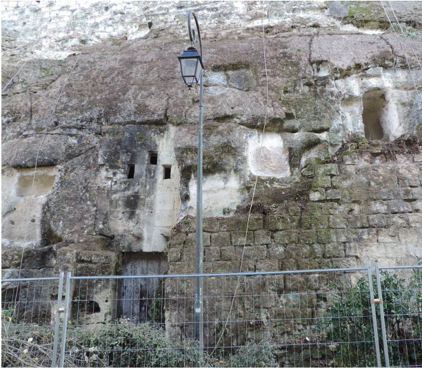
Figure 46 : Cavités correspondant aux reprises récentes d'une galerie de défense médiévale (©Sadil)
