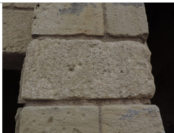
Figure 33 : Exemple d'emploi du tuffeau jaune lors de la reprise du 15 e siècle de la Porte Royale (©Sadil)
