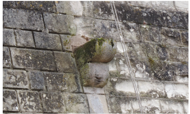
Figure 77 : Console restaurée (UA 65) témoignant peut-être d'un support de hourd antérieur (©Sadil)
