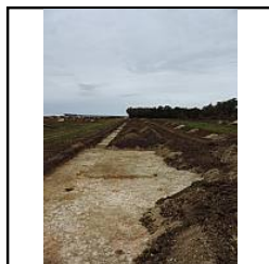
Photo 724 Vue générale du bâtiment Tr.57 - (Silberstein Grégory)
