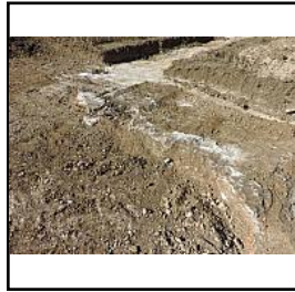
Photo 479 Détail lignes de fracturation - (Silberstein Grégory)
