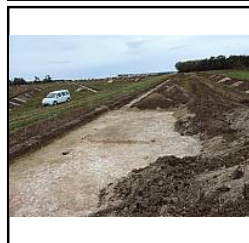
Photo 725 Vue générale du bâtiment Tr.57 - (Silberstein Grégory)
