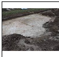
Photo 726 Vue générale du bâtiment Tr.57 - (Silberstein Grégory)
