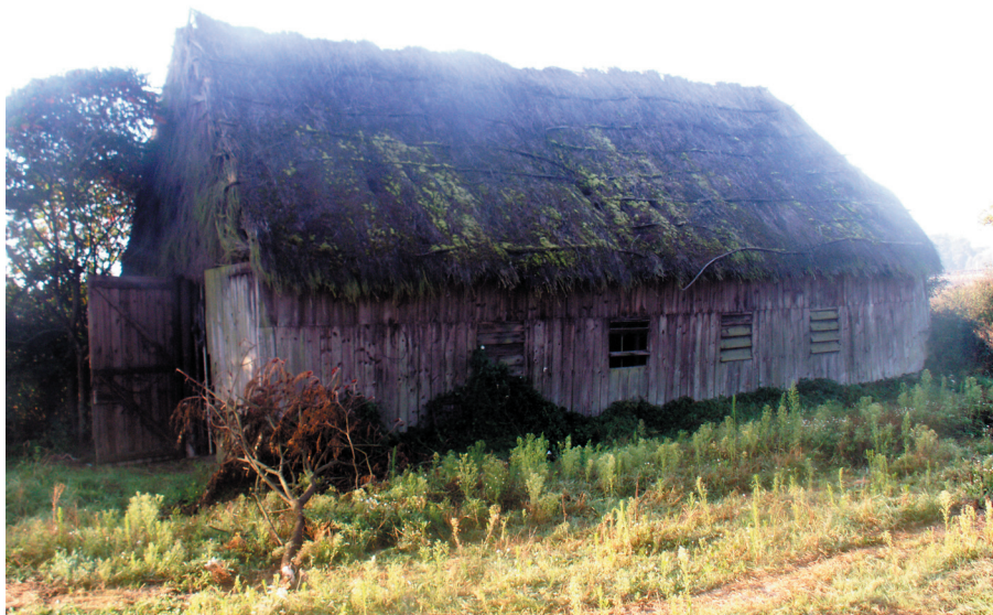
Figure 40 : vue du mur nord du séchoir (M. Gaultier - SADIL)
