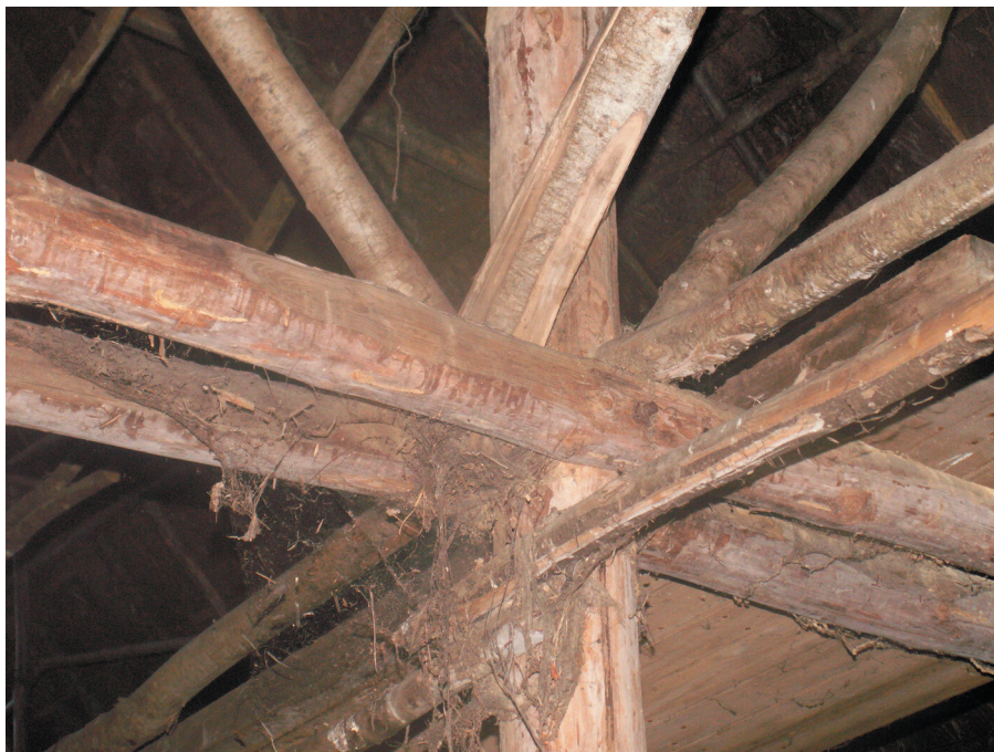
Figure 42 : vue de détail au niveau de la liaison entre le poinçon et l'entrait sur une ferme (M. Gaultier - SADIL)
