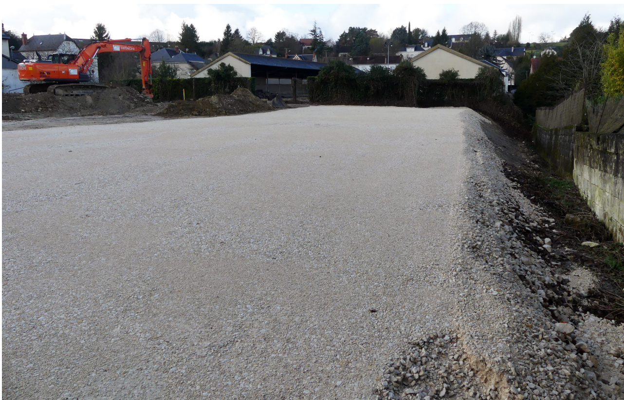
Figure 5 : Vue de la parcelle AX511 : au premier plan, la zone dépolluée avant l'intervention (anciennes cuves) ; à droite, on constate la pente du terrain environnant et la situation en remblai des parcelles prescrites.
