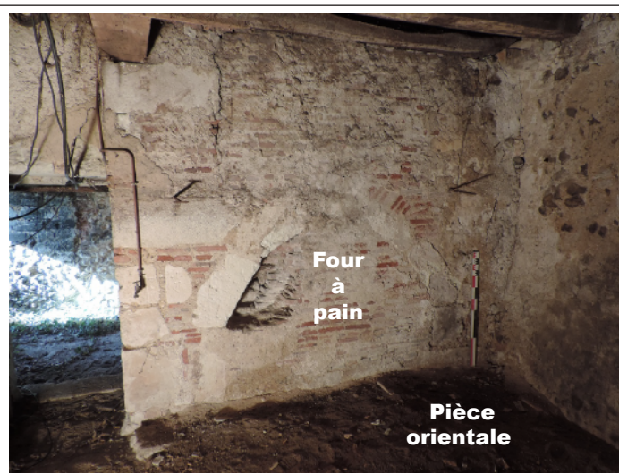
Figure 59 - Installation d'une cheminée avec four à pain dans le refend transversal de la cave (Sadil)
