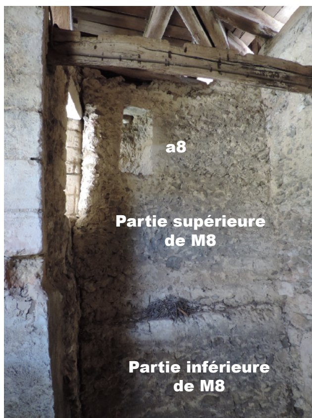
Figure 49 - Tourelle sud, construction sur deux étages de M8 : partie inférieure plus large pour supporter le plancher du second étage, partie supérieure correspondant à une reconstruction du mur originel du second étage
