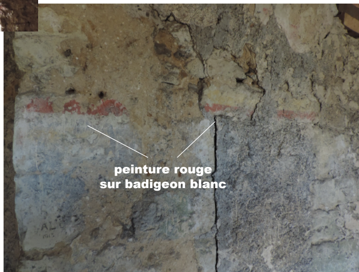
D - Traces de peinture à l'angle du mur est et de la tourelle nord au 2 e étage (Sadil)
