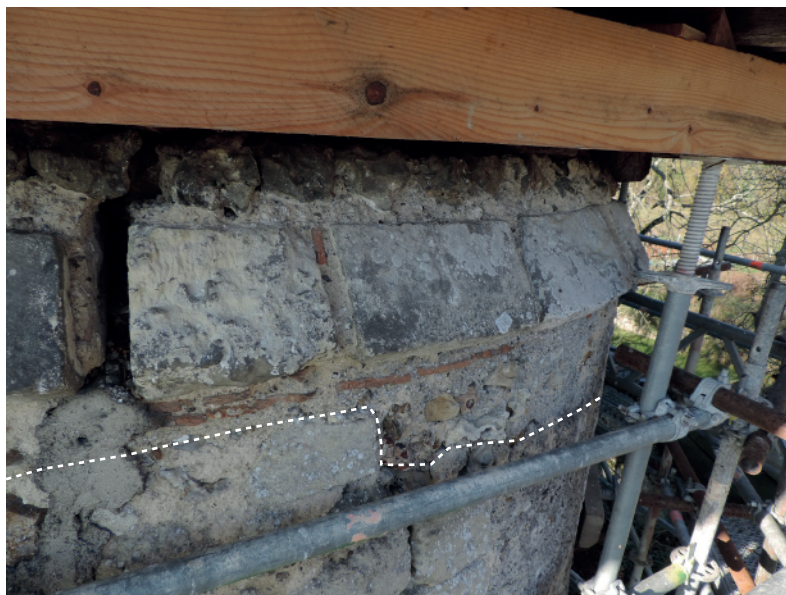
Figure 40 - Larmier de la phase 2, remonté lors de la phase 9 (Sadil)
