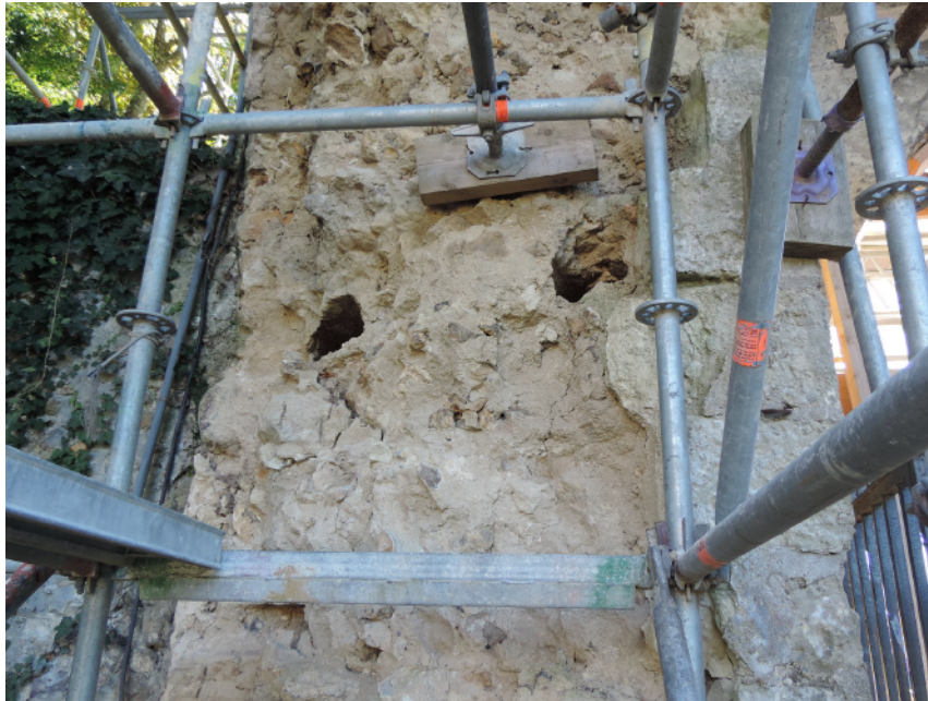
Figure 44 - Exemples de deux trous de poutre dans le bocage de la tourelle nord, vue depuis l'ouest (Sadil)
