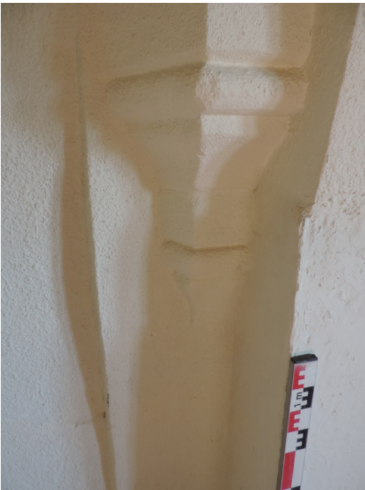
A - Culot gauche de la console de la cheminée du rez-de-chaussée (Sadil)
