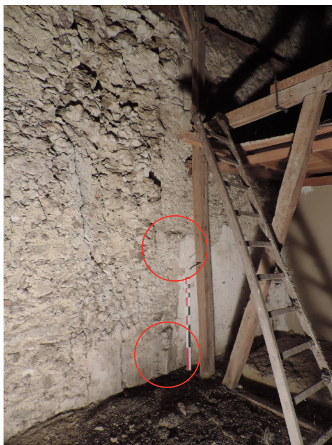
Figure 43 - Pierres bûchées d'orientation différente formant les vestiges probables d'un escalier
