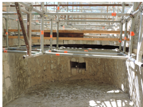
B - Vue de l'assomoir et du couloir de herse dans la voûte v2 (Sadil)
