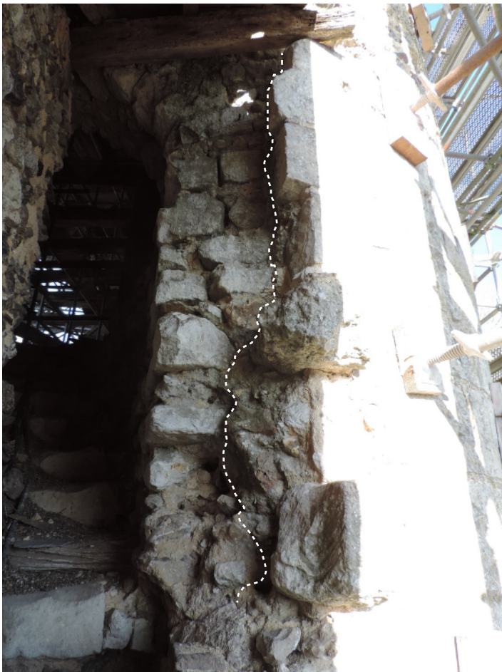
A - Insertion maladroite du piédroit oriental de la porte p1 dans les pierres de taille de la tourelle sud (Sadil)
