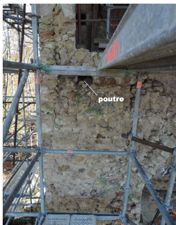
B - Vue du blocage derrière le «raidisseur» plat effondré (Sadil)
