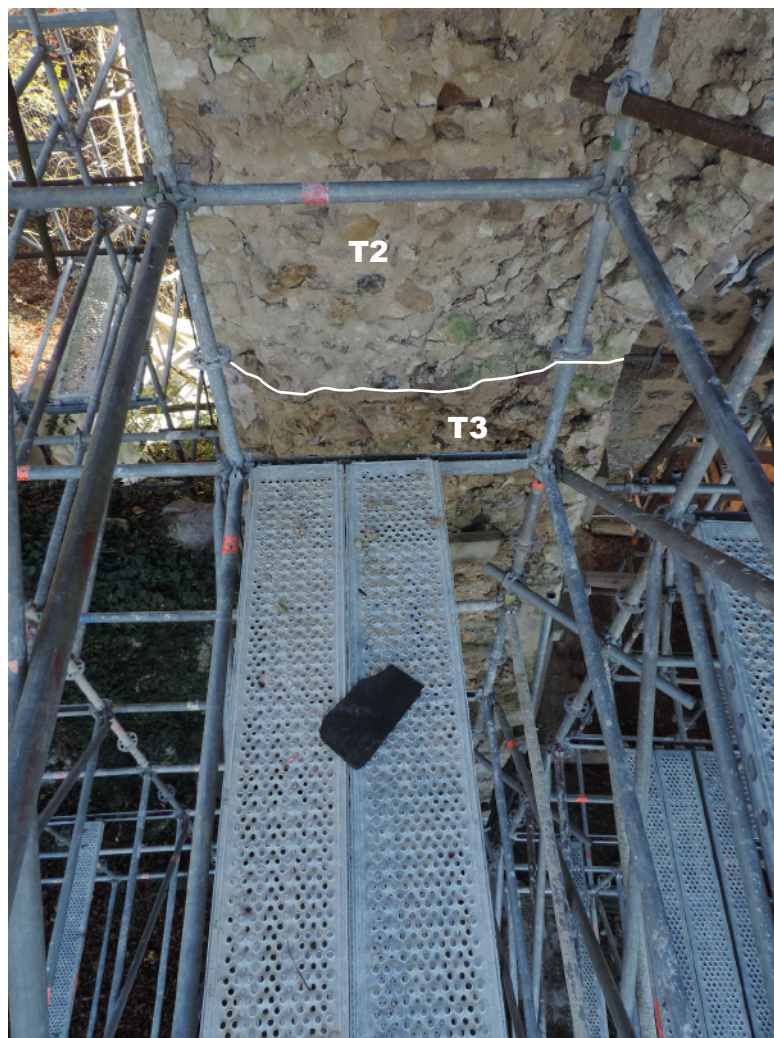
A - Différence dans la couleur des mortiers au revers de la tourelle nord (T2 et T3) (Sadil)
