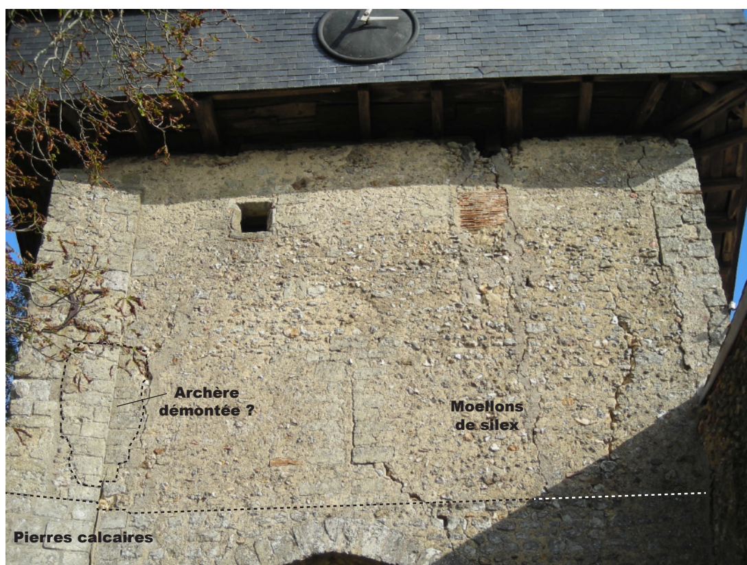
B - Rupture horizontale visible dans la construction avant l'effondrement, au-dessus de l'arrière voussure v1 (Service Patrimoine de Château-Renault)
