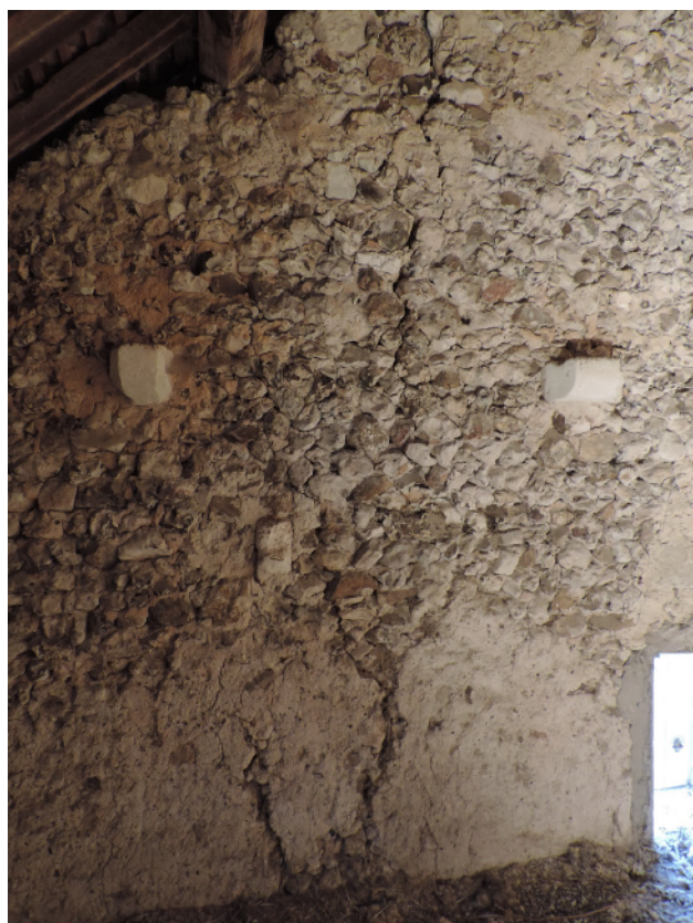
Figure 55 - Corbeaux témoignant d'un étage intermédiaire dans les combles de la maison accolée (Sadil)
