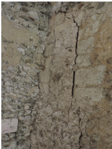
A - Exemple d'archère du 2 e étage, archère a6 bouchée dans l'angle sud-ouest (Sadil)
