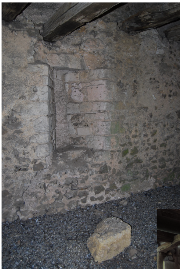
A - Archère a1 dans le mur ouest du 1 er étage (Service Patrimoine de Château-Renault)
