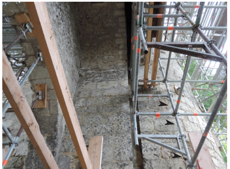
B - Vue du délardement du pan sud de la tourelle nord, depuis le passage d'entrée (Sadil)
