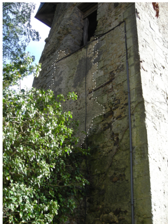
B - Détail depuis le nord de la destruction ragrée de la partie supérieure de la cortine nord, avant effondrement (Service Patrimoine de Château-Renault)
