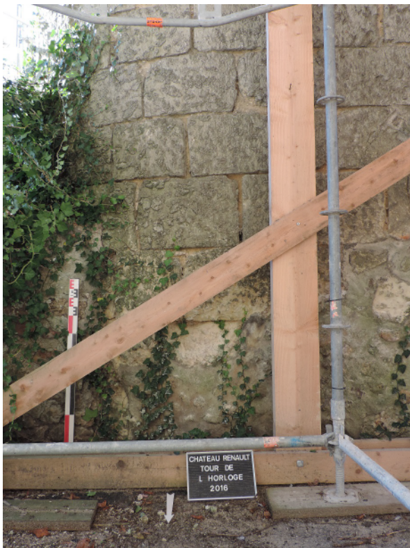
A - Détail du moyen appareil de pierre de taille de la tourelle sud (Sadil)
