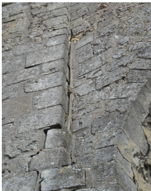
Figure 21 - Vues du «raidisseur» dans l'angle nord-ouest de la tour avant et après effondrement
