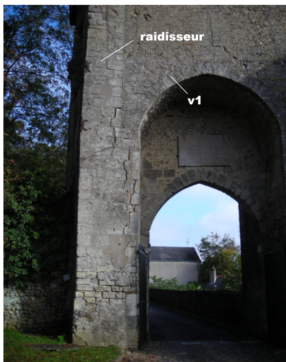
A - Vue du «raidisseur», avant effondrement, au nord de l'arrière-voussure (v1) et correspondant selon Christian Corvisier au reste du mur latéral nord d'un étage disparu (Service Patrimoine de Château-Renault)
