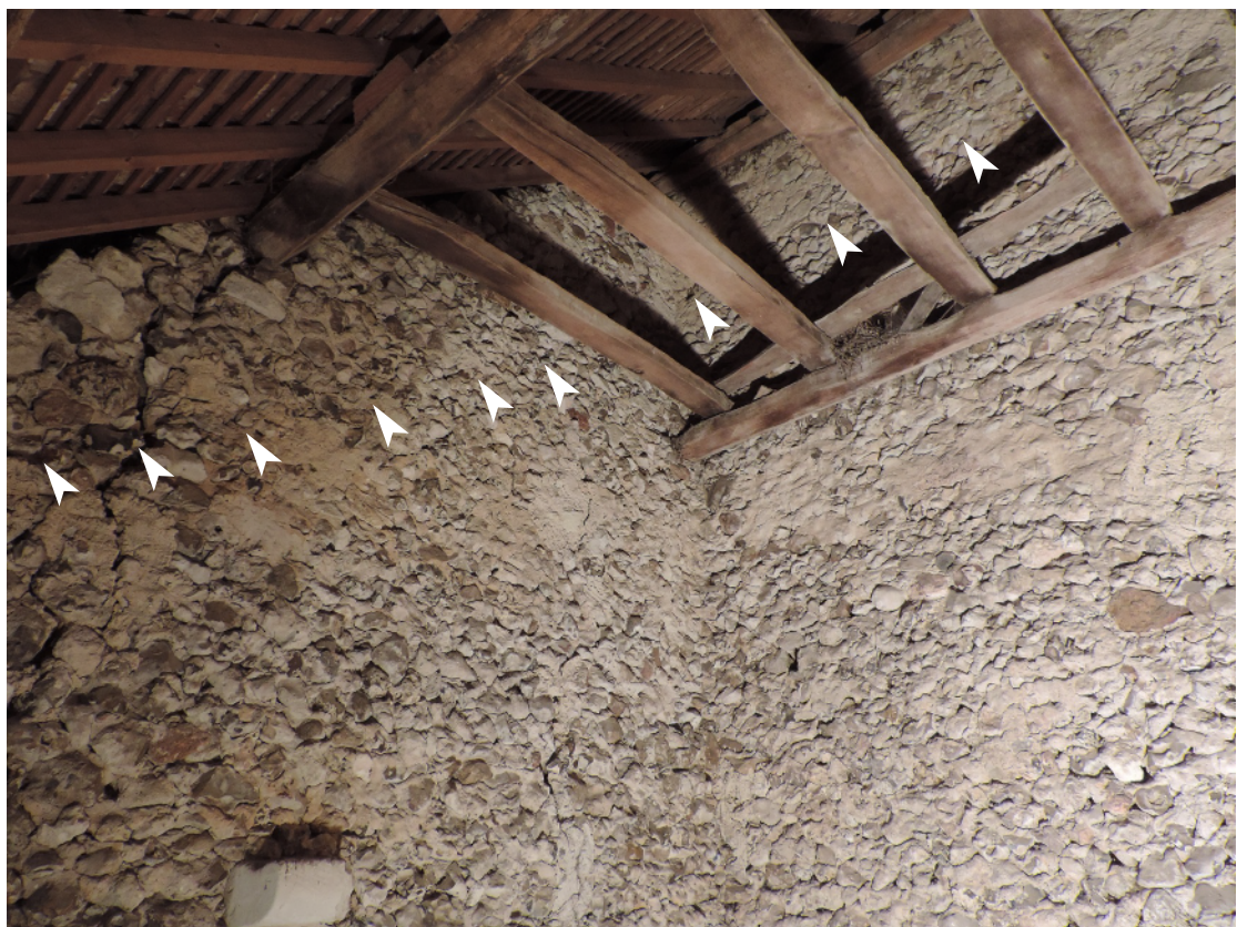
Figure 53 - Vue de la trace oblique de l'ancien toit avant son rehaussement (Sadil)
