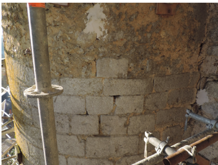
A - Détail de la transition entre les deux types d'appareil sur la tourelle sud (Sadil)
