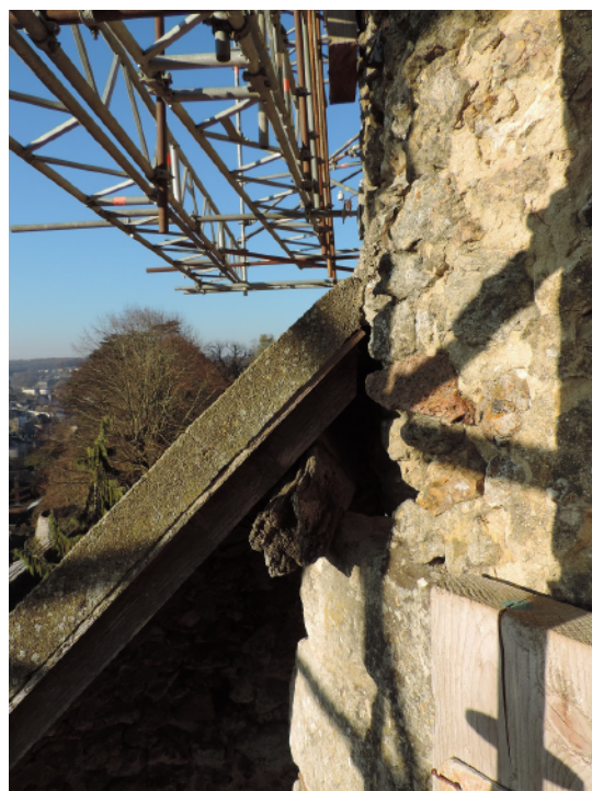
B - Détail du léger retrait du parement des étages par rapport au rez-de-chaussée (Sadil)
