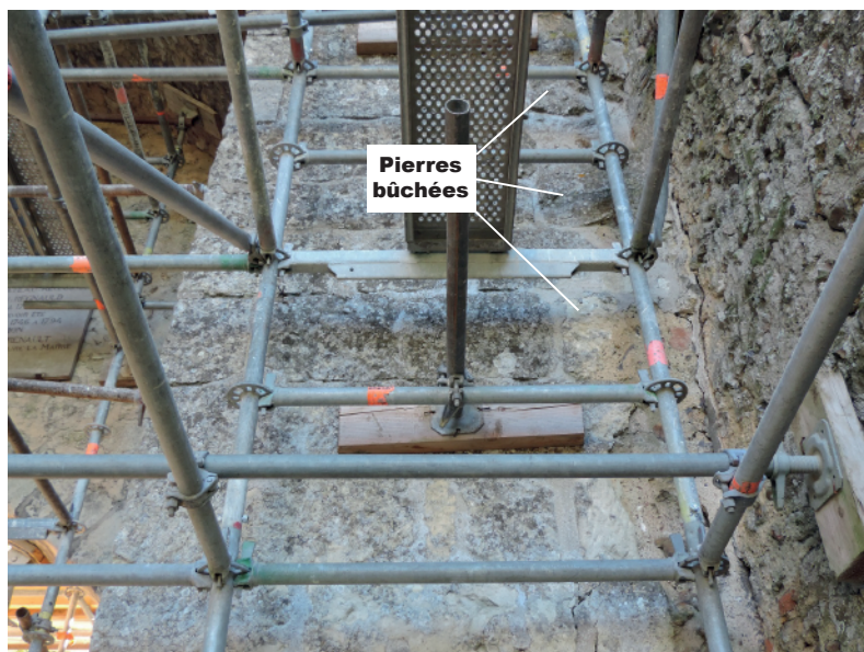
A - Pierres bûchées témoignant de la destruction d'un contrefort, côté ouest (Sadil)
