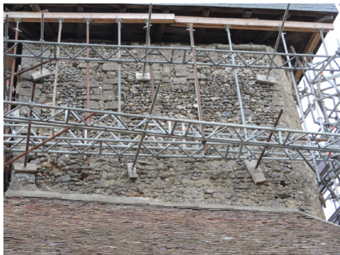
B - Vue des moellons des étages de la tour (Sadil)
