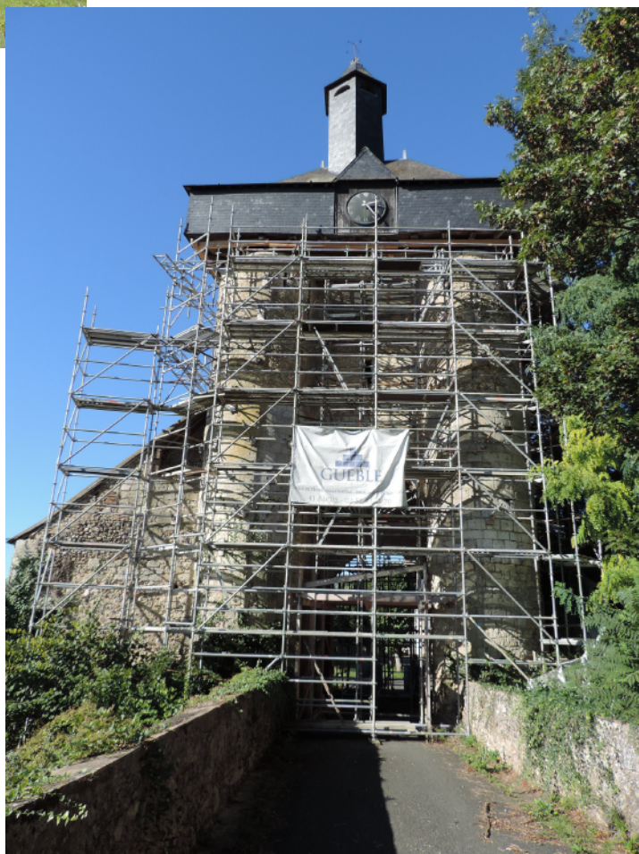
Figure 5 - Vues de la tour de l'Horloge après mise en place de l'échafaudage servant d'étais
