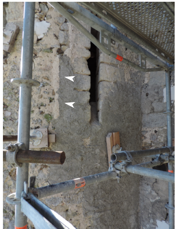
Figure 46 - Témoins de la reconstruction du parement du second étage de la tourelle nord
