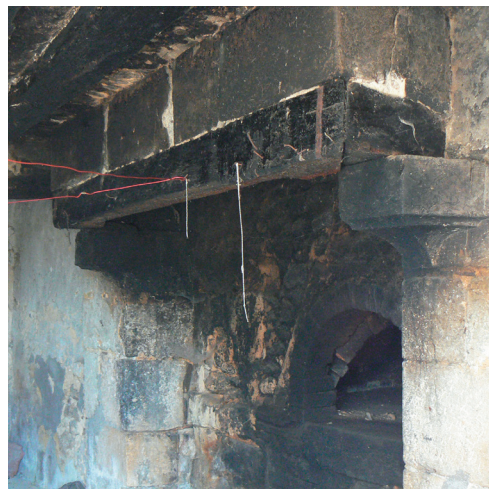
Photographie 2 : Cheminée typique du 15e siècle avec ses corbeaux de pierre de forme triangulaire ouvrant sur le four à pain
