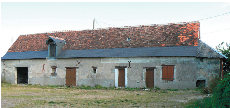
Photographie 1 : Vue de la façade sud de la ferme-bloc du Clot. De gauche à droite on trouve la partie grange (ajoutée au 19e s), la partie étable, la partie habitat (cuisine et chambres), et un apentis abritant l'escalier menant aux combles et l'abside du four à pain.
