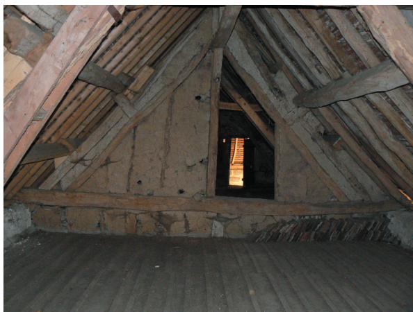
Photographie 3 : vue de la partie ouest des combles. On remarque en arrière plan la séparation à pan de bois et torchis
