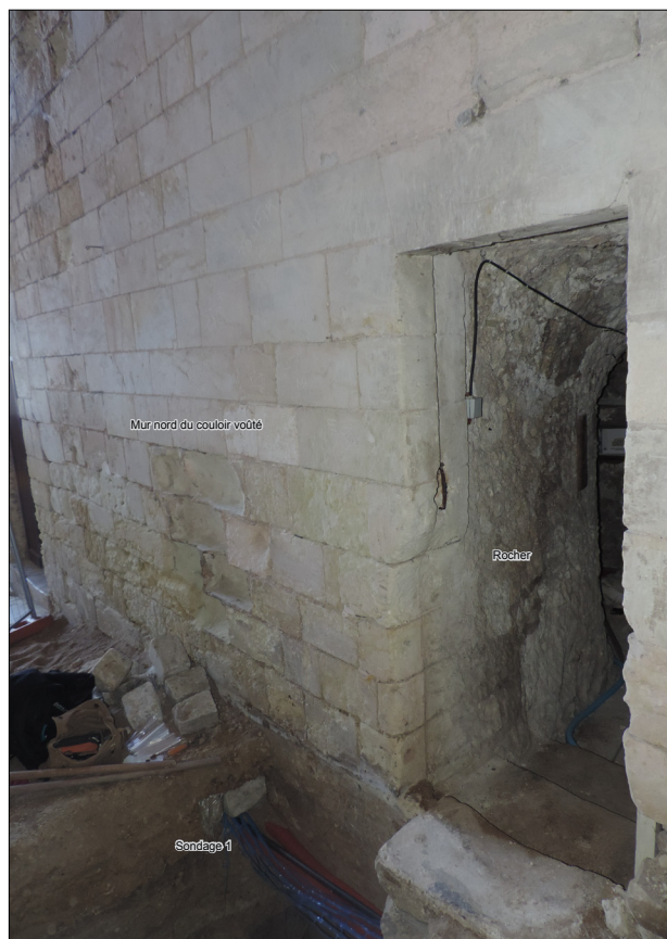
Figure 12 : vue du mur nord du couloir voûté reposant contre le rocher
