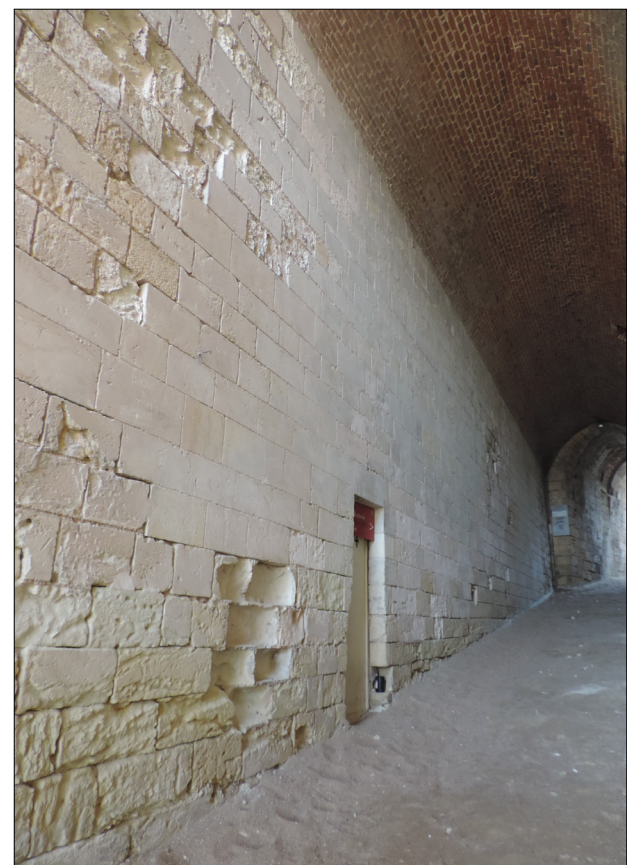
Figure 13 : vue des deux phases du mur nord du couloir voûté
