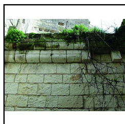
Photo 111 Détail de la restauration de l'arase de M1 - (Pellerin Kevin)
