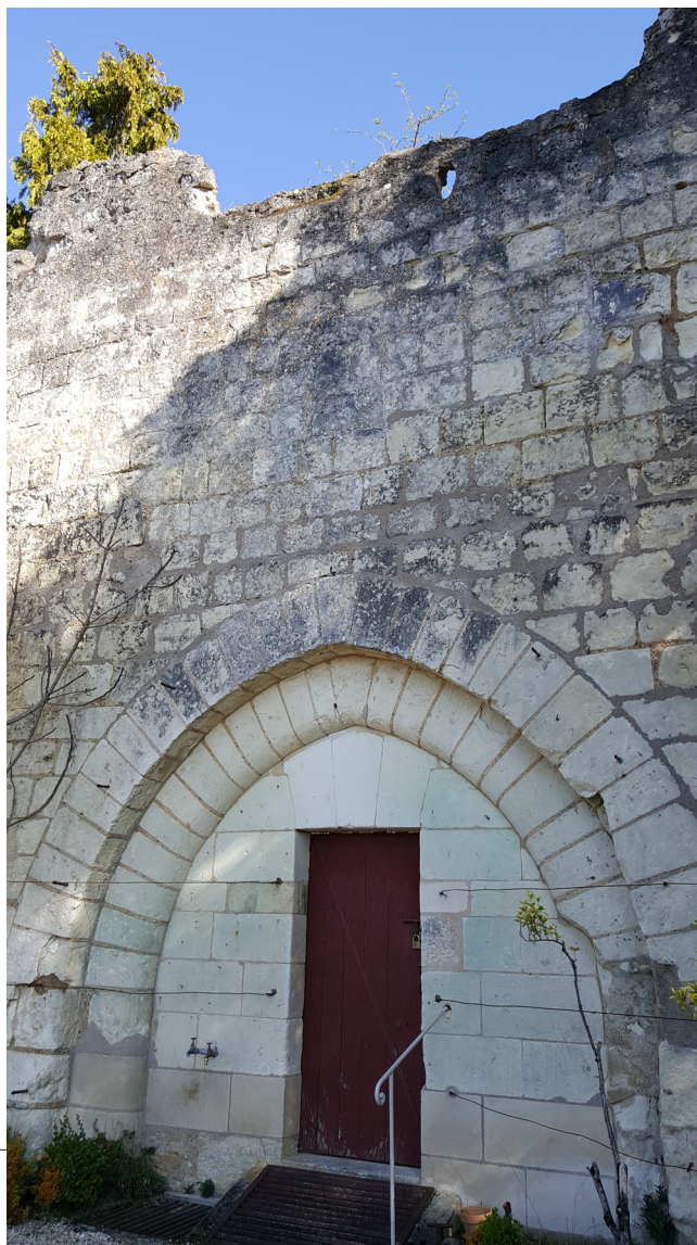
Figure 41 : Vue de la portion conservée de l'enceinte de la fin du 11 e s. au nord de la «Tour-Neuve», avec son crénelage fossilisé par une surélévation
