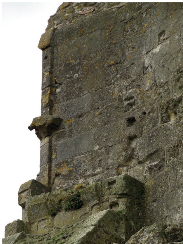
Figure 67 : Vue de détail des restes de la fenêtre à meneau et à coussiège F12, mur ouest de l'aile sud (M3)
