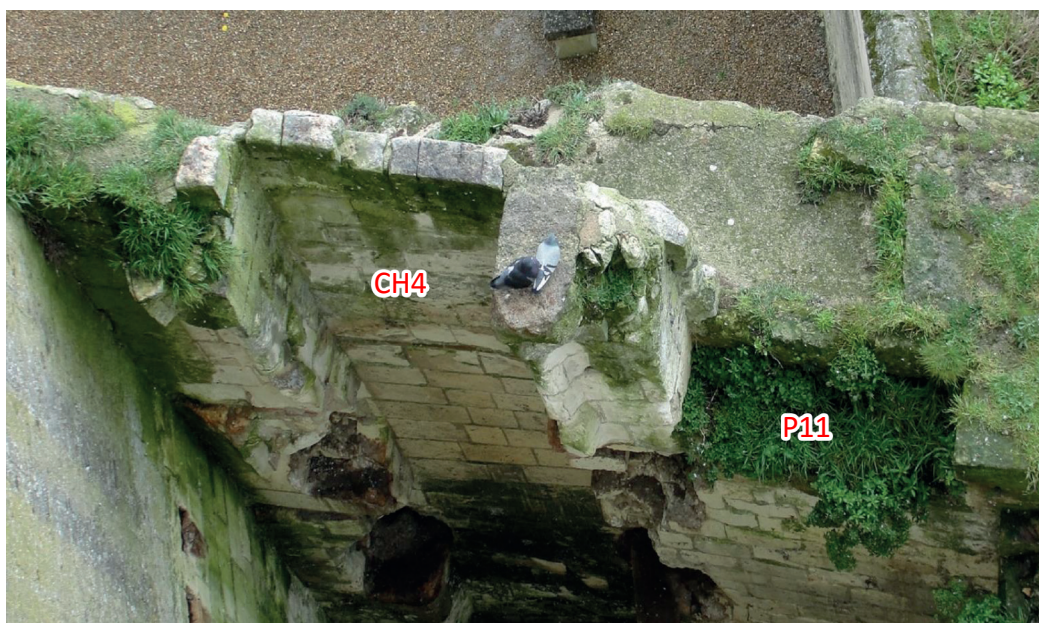
Figure 66 : Vue des restes de la cheminée CH4 et de la porte P11, sur l'arase du mur sud (M5) (cliché K. Pellerin).
