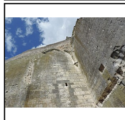
Photo 25 Arrachements des voûtes, niveau 3 - (Pellerin Kevin)
