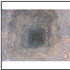
Photo 31 F 102 : Fond avec vue sur les encastrement soulignés par un tracé - (Féménias Jean-Marc)
