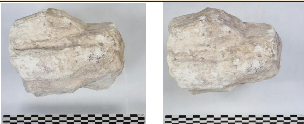
Fig. 73 et 74 : Face d'ébrasement (1) avec feuillure de vitrail du lot 625 (M. Beigneux, CD37).
