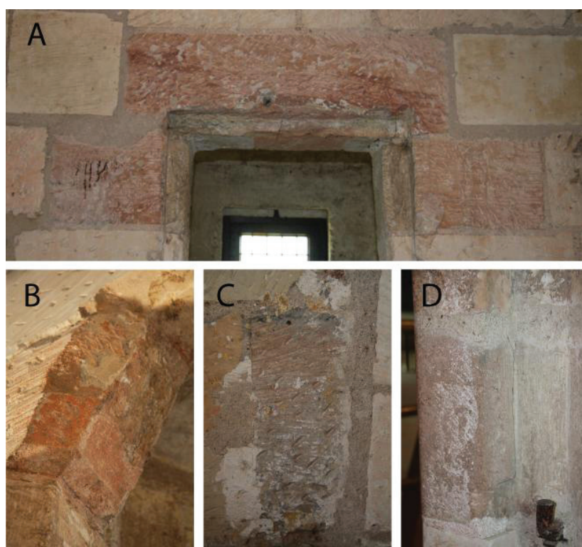
Fig. 32 : Tuffeau jaune employé au logis ducal aux linteaux et coussinets (A et B), aux jambages de cheminée (C) et aux piédroits (D) (S. Bourocher).
