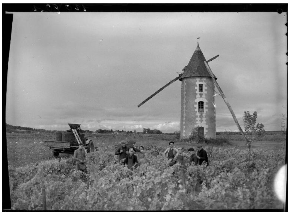
On voit bien sur cette photo d'un moulin à l'abandon la longue poutre (givre) qui servait autrefois à tourner les ailes face au vent.
