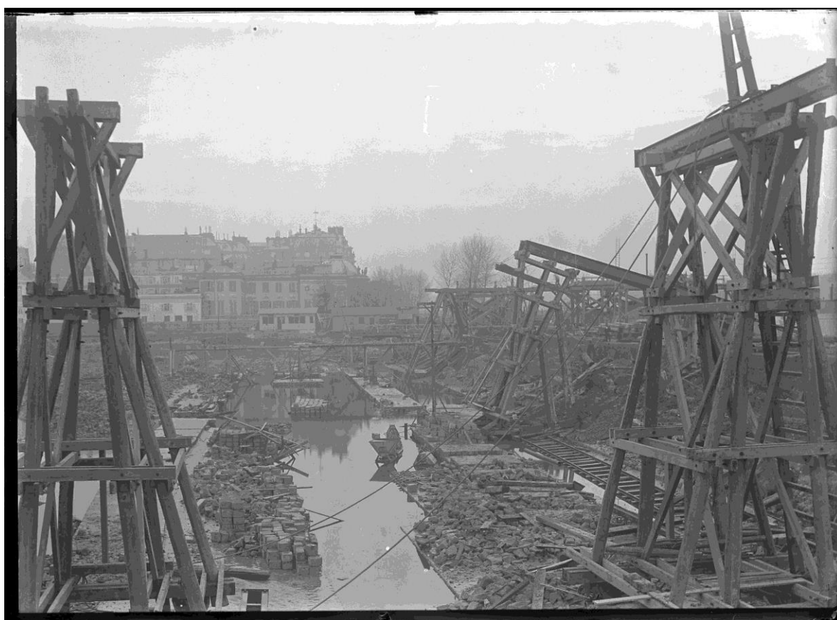
Echafaudages en bois.
