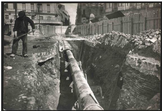
Photo 7 : L. Fachinetti, Pose de canalisation d'égouts place du Capitole , 1910. Epreuve sur papier, 11x16 cm/ Archives municipales de Toulouse, 1Fi234. En bas à droite, élément du rempart antique mis au jour lors des travaux.
