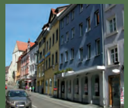
Vue actuelle de la maison d'Anna Hartmann, rue des franciscains à Uberlingen.
