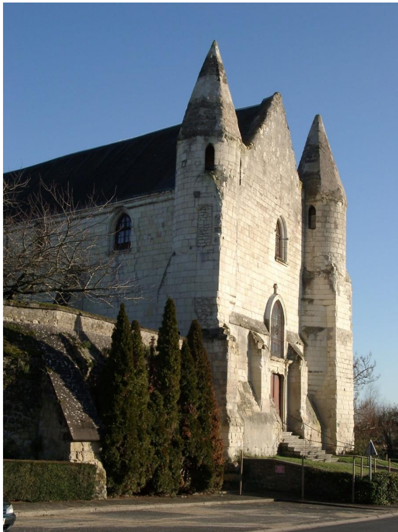
Vue extérieure des grands celliers. 14 e siècle. (cliché N. Bonneau)
