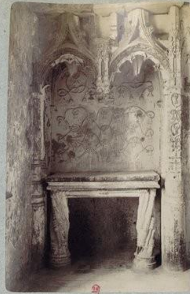
Loches - Portes d'Am. de Bretagne G135500
